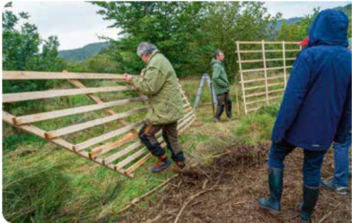
Insgesamt 200 Holzgatter wurden installiert.
