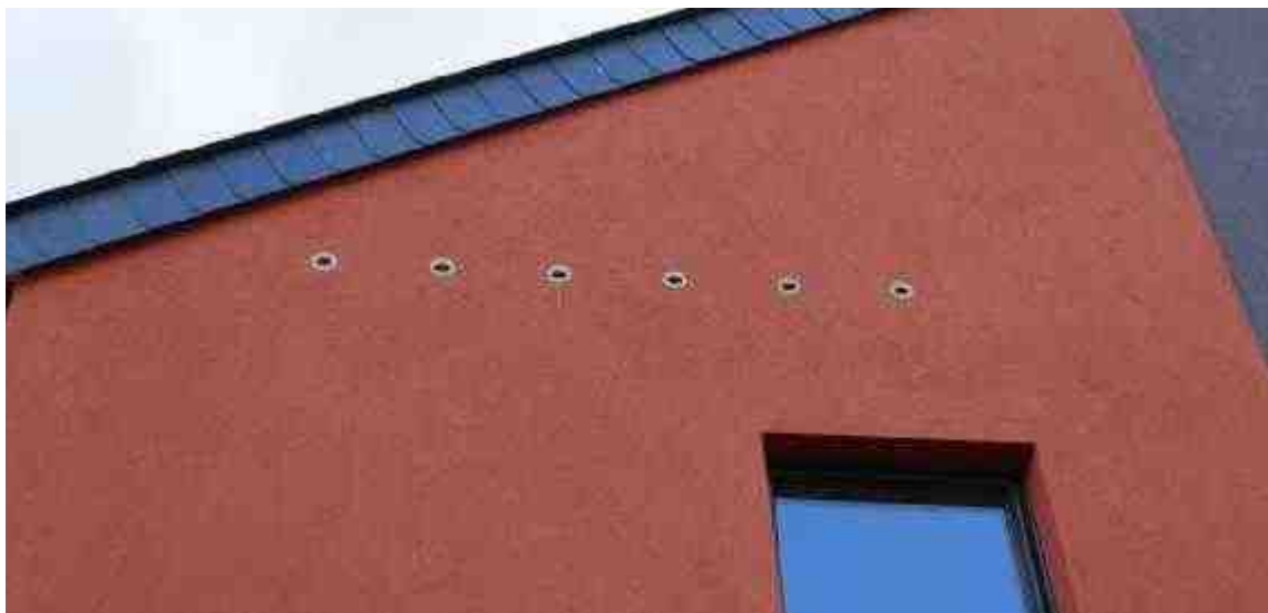
Beispiel 1 Einbau von Mauerseglerniststeinen
